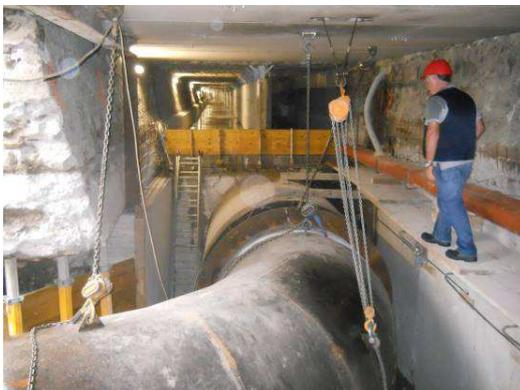
Condotta in acciaio DN2100 di adduzione alla centrale idroelettrica di Corna di Darfo (BS) - Tratto in galleria
