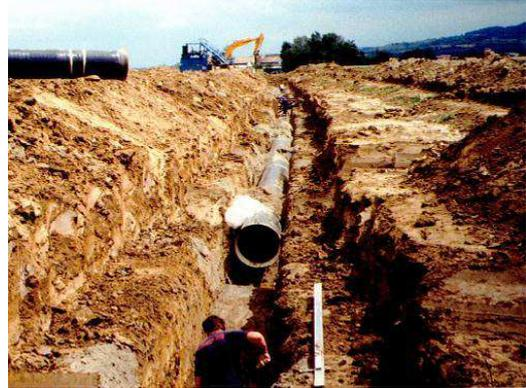
Lavori di posa condotta interrata in acciaio DN800
