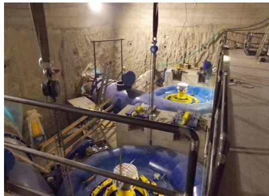
Montaggio delle turbine all'interno della centrale idroelettrica interrata di Corna di Darfo (BS)
