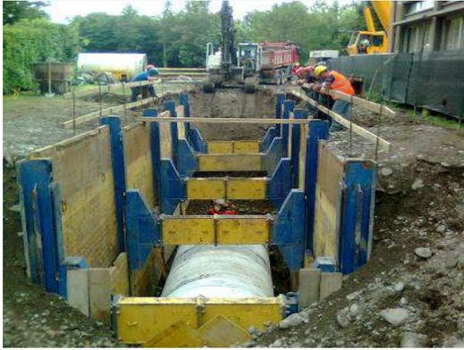
Condotta in acciaio DN2100 di adduzione alla centrale idroelettrica di Corna di Darfo (BS)
