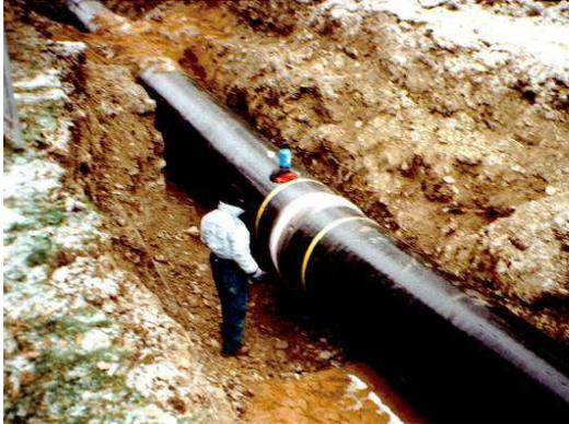
Lavori di posa condotta interrata in acciaio DN1000
